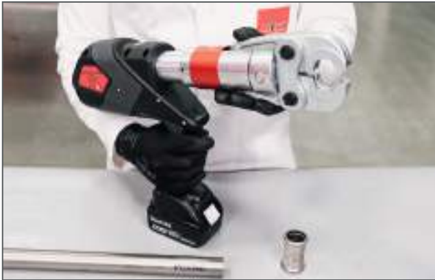
Preparazione della macchina pressatrice / Press machine preparation
